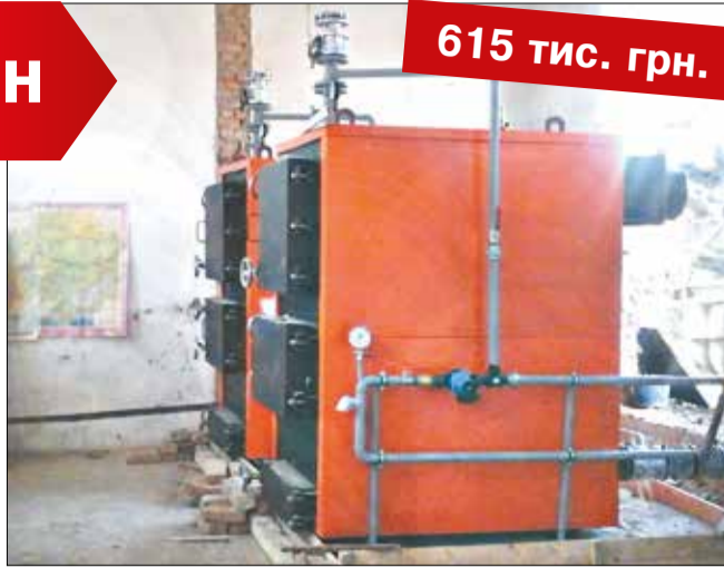
Встановлення твердопаливних котлів НВК «ЗОШ №1 ім. М.Д. Леонтовича – гімназія» у м. Немирів
